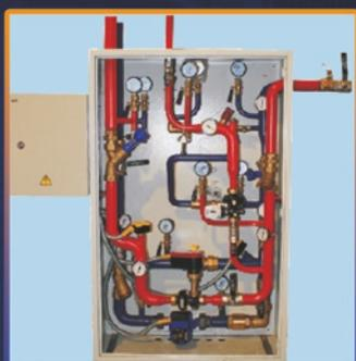
При общей установочной тепловой мощности до 100кВт БТП выполняется в виде шкафного теплового пункта (ШТП)
